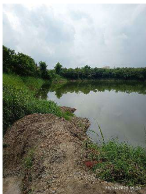
รูปที่ 17 การนำกากตะกอนจากระบบผลิตน้ำประปาไปเสริมคันดินบ่อเก็บน้ำฝน
